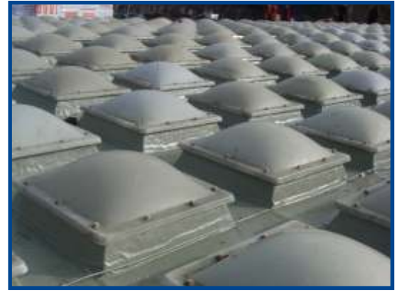
Flachdachabdichtung mit FRANKOLON® Abdichtung
