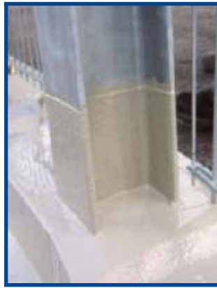
Detaillösung mit FRANKOLON® Abdichtung thix
