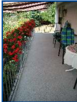
Abdichten eines Balkones mit FRANKOLON® Abdichtung und Dekorschicht
