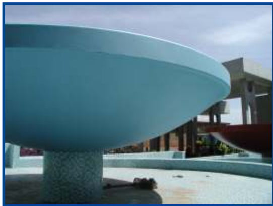
Abdichten eines Brunnens mit FRANKOLON® thix. Farbliche Gestaltung mit Colorschicht.
